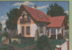
Budynek Gnieszewo. Wypowiedź właściciela domu: — Ciepło, ciepło i jeszcze raz ciepło.
