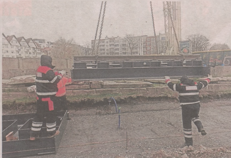
Kolejowa waga została wmontowana w torowisko. Działa od 7 marca
