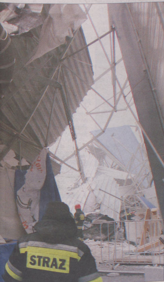
ich runął na kilkuset przebywających w środku ludzi. Prawo- trzymała naporu śniegu. Polska norma dopuszcza nacisk etr kwadratowy dachu budynku.
