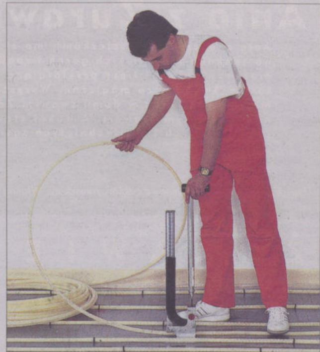
(al) Układanie ogrzewania podłogowego.
