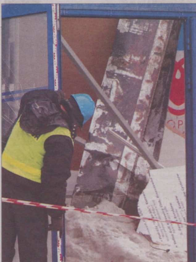
Tragedię na Międzynarodowych Targach w Katowicach mogło spowodować kilka czynników, np. rozszczelniona konstrukcja dachu, drgania wywołane pracą wentylatorów czy oddziaływanie na konstrukcję fal akustycznych głośnej muzyki.
