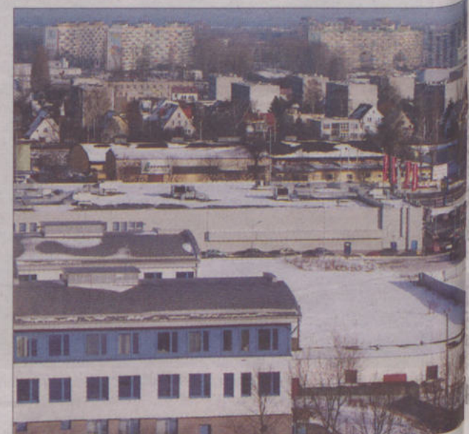
Duże budynki z płaskimi dachami na Pomorzu pomyślnie przeszły kontrolę. Żadnego z nich nie trzeba zamykać.
