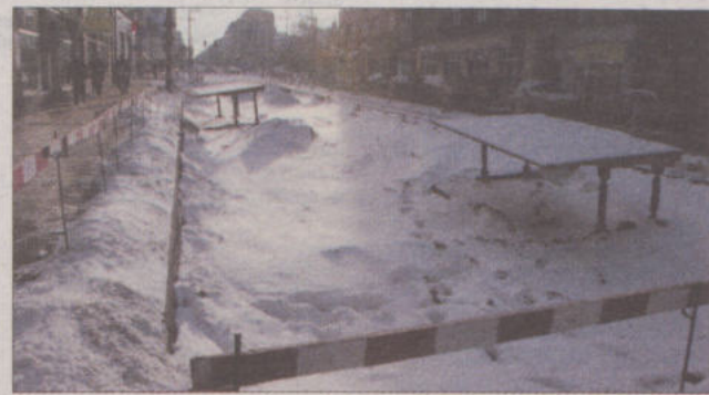
Na remontowanym obecnie fragmencie ul. Świętojańskiej nic się nie dzieje. Prace ze względu na mróz zostały wstrzymane.
