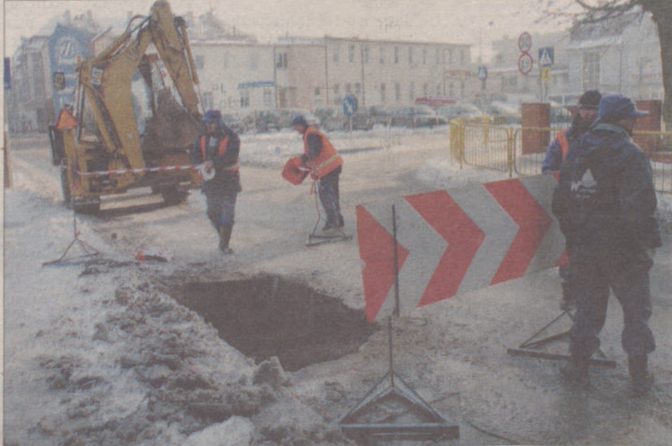
Usuwanie awarii rury wodociągowej na ulicy Deotymy w Słupsku.
