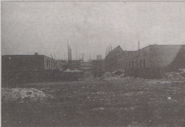
Prace budowlane przy ul. Prusa, prawdopodobnie początek lat trzydziestych XX wieku. Pokazujemy je jako pierwsi.
