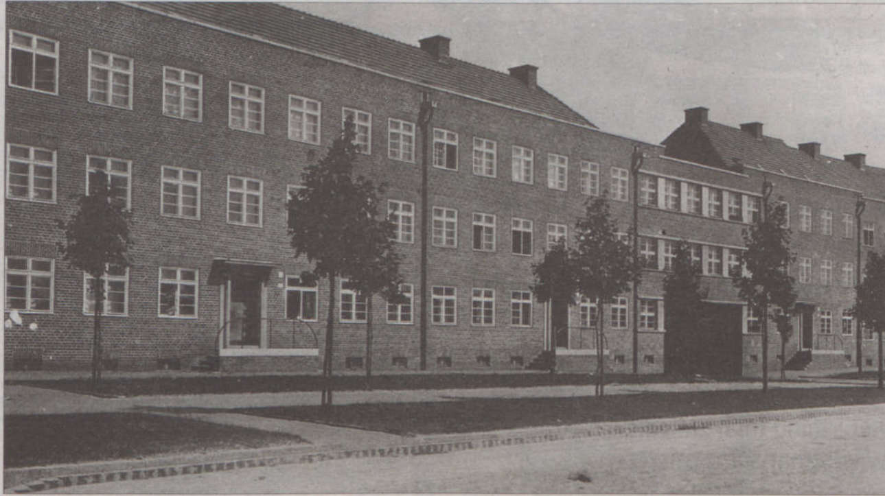
Domy przy ul. Kościuszki 50, 52 i 54 w Gdańsku. Zbudowała je firma Rudolfa Hoffmanna juniora.
