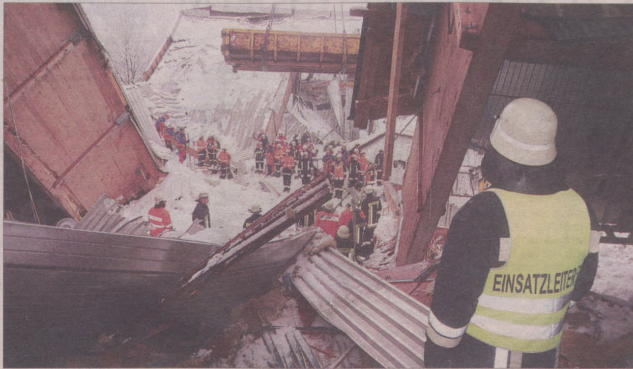
Ratownnicy pracują na miejscu tragedii, gdzie w poniedziałek w Bad Reichenhall w Bawarii pod ciężarem śniegu zawalił się dach krytego lodowiska.
