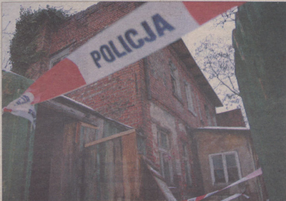
W tym budynku, od lat przeznaczonym do rozbiórki, w niedzielę w nocy spłonął bezdomny mężczyzna.
