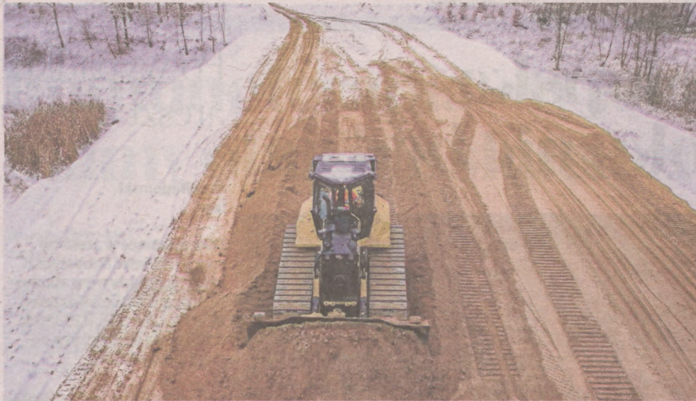
Drogowcy przekopali się już przez wzgórze, które przegradzało niekiedy przyszłej ulicy
