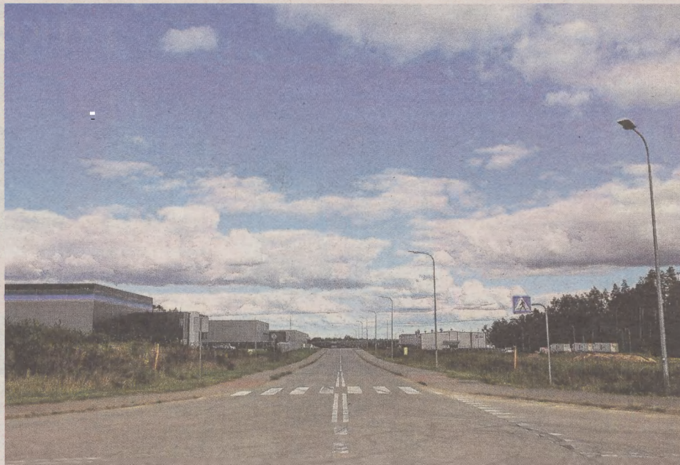
Umowę podpisano na uzbrojenie niezagospodarowanych obszarów strefy przemysłowej po we wschodniej i północno-wschodniej części Słupska
