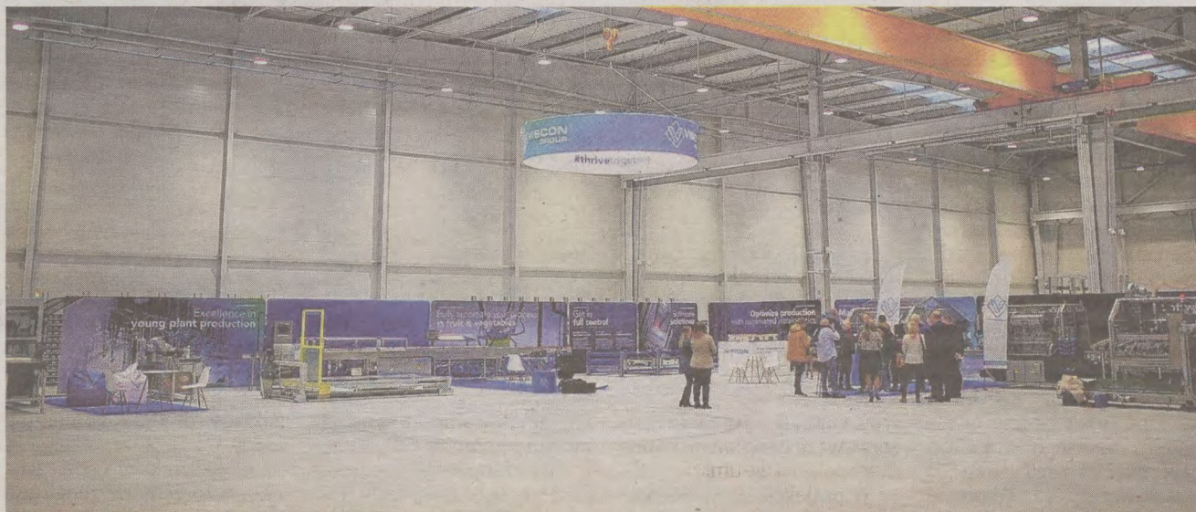
Viscon pojawił się w Słupsku 10 lat temu. W 2019 r. firma wybudowała nowy zakład na terenie Słupskiej Specjalnej Strefy Ekonomicznej w Płaszewku. Obecnie został rozbudowany o nową halę (na zdjęciu)
