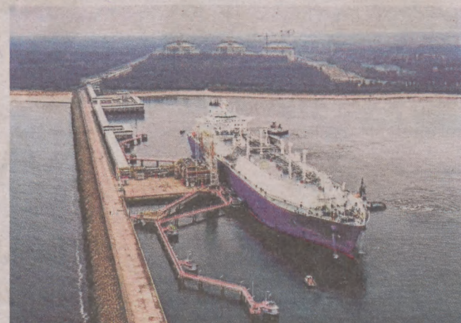
Gazoport się rozbudowuje. Trzy zbiorniki i jedno nabrzeże do rozładunku to już niedługo będzie tylko jego część
