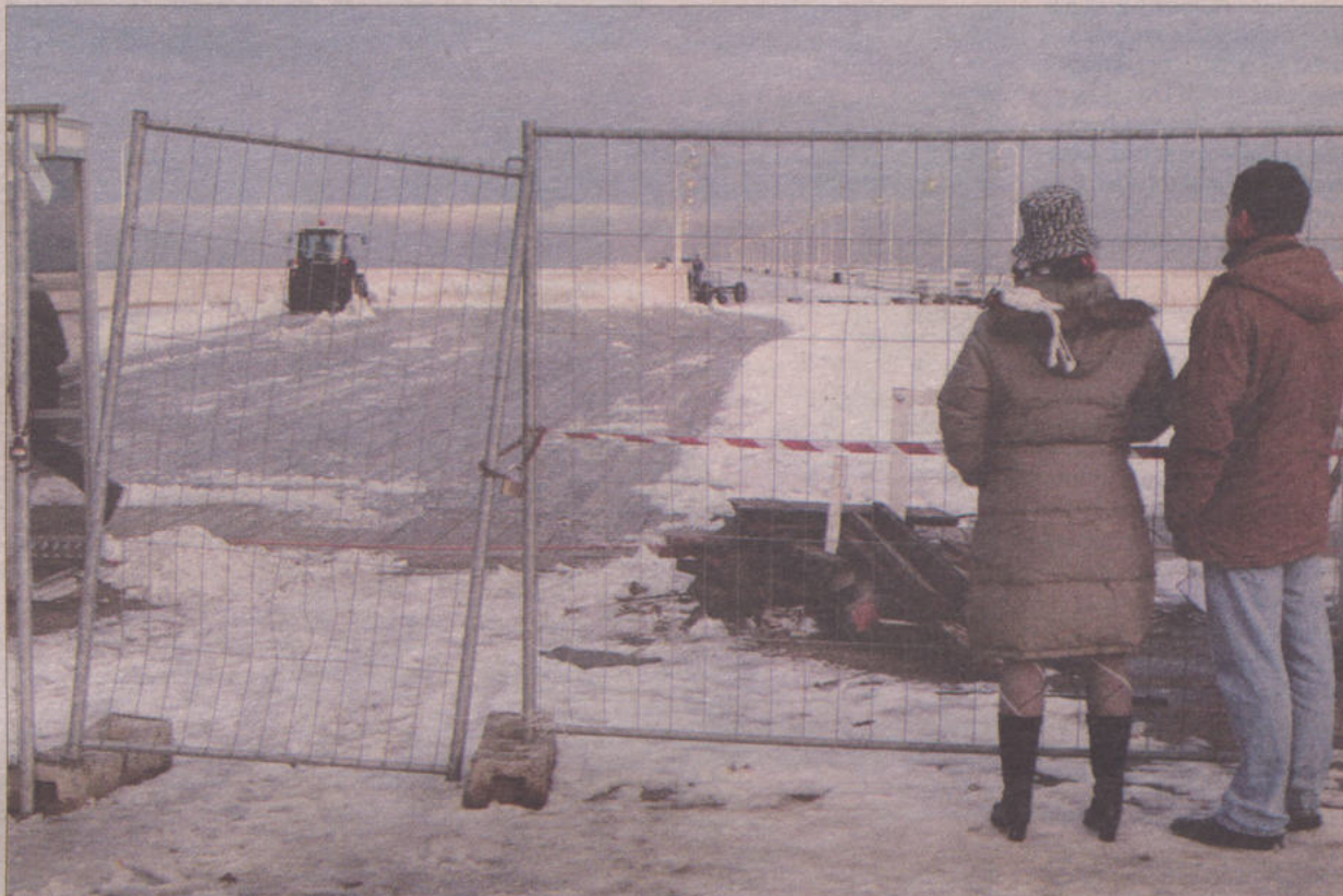
Prace remontowe dobiegają końca. Jutro okaże się, czy molo zostanie jeszcze w tym roku otwarte.
