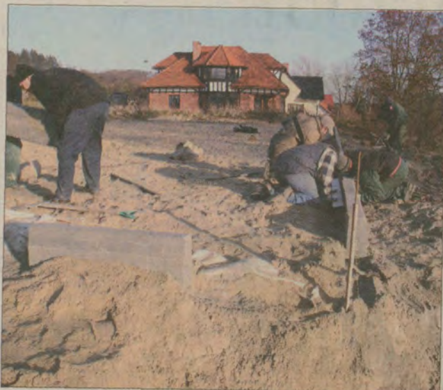
Trwają prace przy budowie boiska do koszykówki w Przywidzu.
