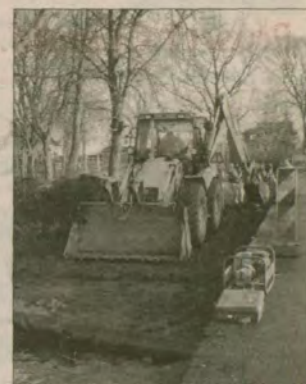
W Roszkowie trwa budowa zatoczek autobusowych.
