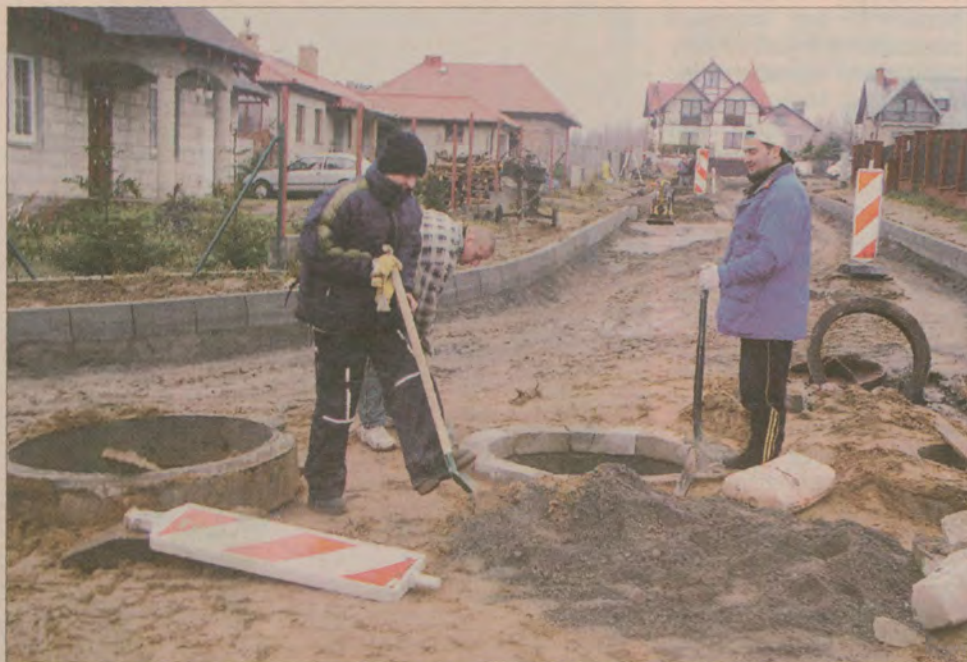
Na Osiedlu Kwiatowym w Straszynie rozpoczęto układanie kanalizacji burzowej.
