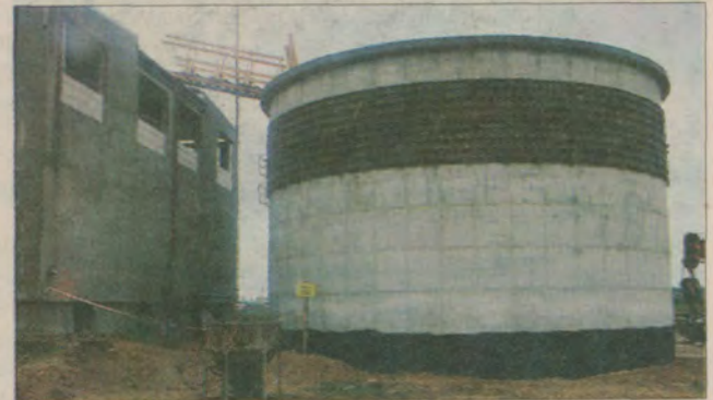
Oczyszczalnia ścieków w Cedrach Wielkich po trzech miesiącach rozbudowy i modernizacji.
