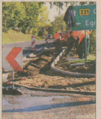
Trwa remont chodnika przy drodze wojewódzkiej nr 221 w Przywidzu.
