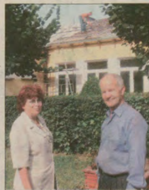
Mirosława Polanowska, dyrektor Szkoły Podstawowej w Giemlicach chwali firmę Zdzisława Ludwiczaka za porządek na budowie.
