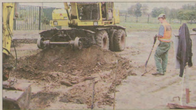
Mieszkańcy Komarowa długo czekali na remont ul. Dywizjonu 303. Prace właśnie się rozpoczęły. Potrwają do przyszłego roku.
