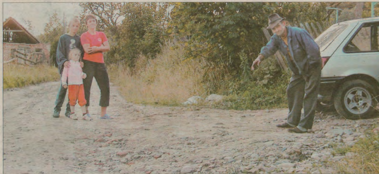
- Gdy pada deszcz nasza droga zamienia się w rzekę - pokazuje Jerzy Kryszczyński z Marszewskiej Kolonii. - Angelika i Kamil przychodzą wtedy do domów całe ubłocone - dodaje ich mama Katarzyna Erdmann.
