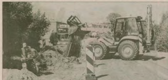
Na remontowanej drodze nr 221 w Kolbudach kierowcy mogą spodziewać się utrudnień w ruchu.
