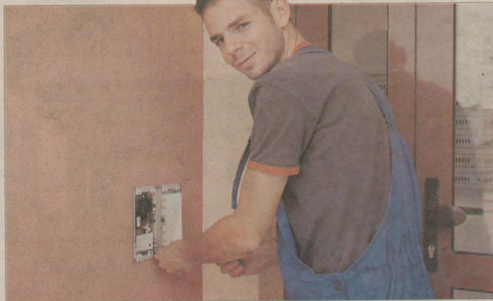
Dzień przed oddaniem do użytku domu TBS przy ul. Cichej 1, Marek Aniołkowski zamontował domofon przed klatką schodową.
