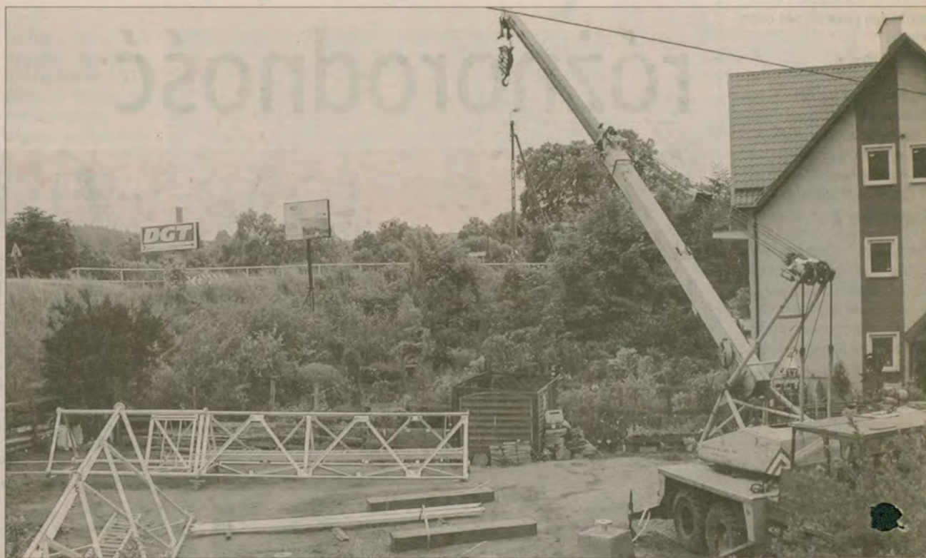
Roboty wstrzymane. Pracownicy zamknęli plac budowy na kłódkę i poszli do domu.
