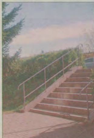
Schody do budynku przy ul. Łukasiewicza - jedna z wielu barier architektonicznych w Pruszczu.
