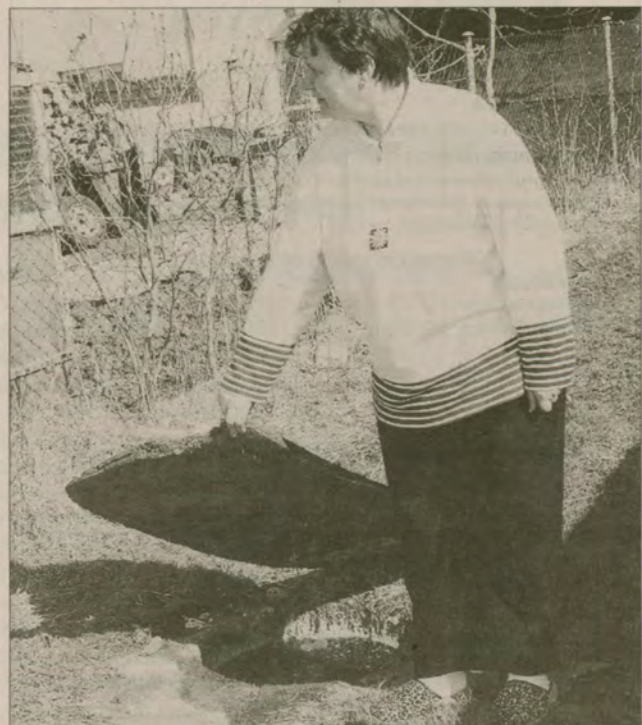
Niezabezpieczony zbiornik na nieczystości przykryty jest zbutwiałą płytą - pokazuje Irena Machuta. Fot. W. Rozenberg
