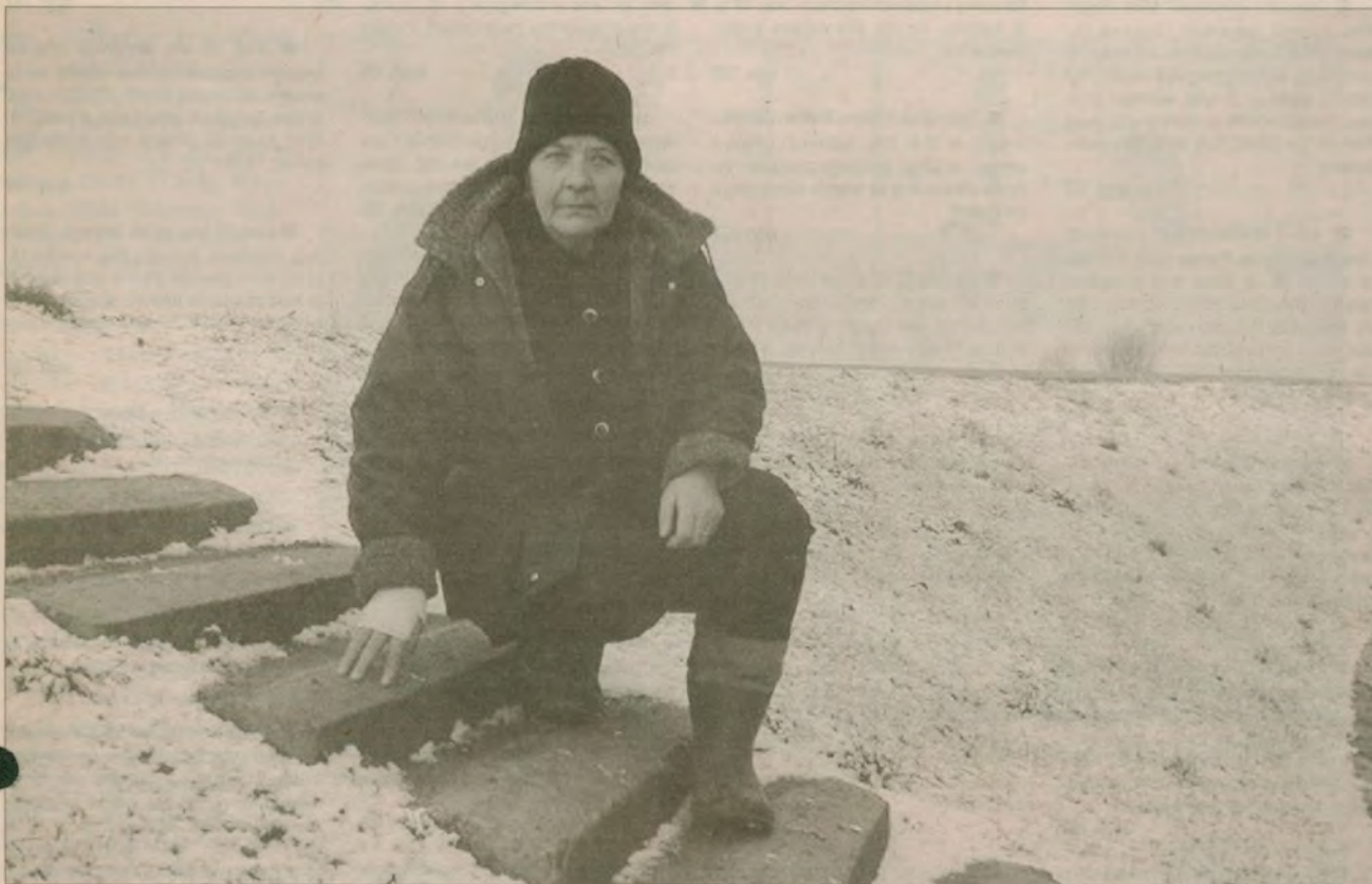
Schody są tak nieforemne i krzywe, że trudno utrzymać na nich równowagę.
