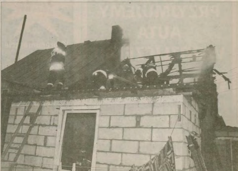
Dach przybudówki spłonął zupełnie.
