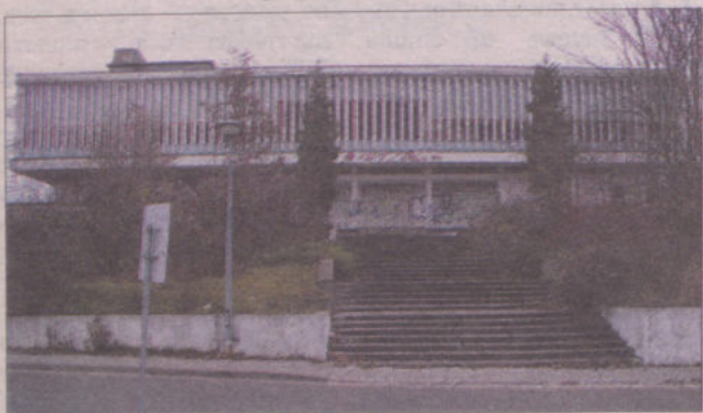
W miejscu zrujnowanego budynku Domu Turysty ma powstać centrum hotelowo-konferencyjne.
