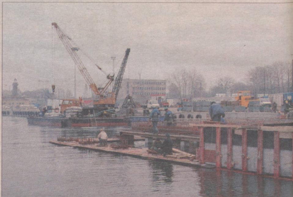
Ekipy firmy Korporacja Budowlana Doraco z Gdańska zakończyły w tym roku odbudowę pierwszego odcinka nabrzeża WOC II na terenie Wolnego Obszaru Celnego w porcie gdańskim.
