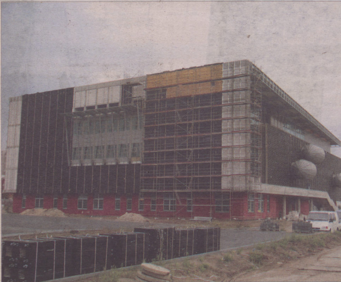
Budowa Biblioteki Głównej Uniwersytetu Gdańskiego.
