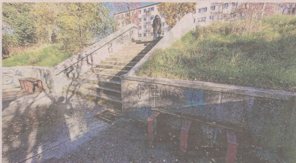
Schody prowadzące z ul. Brzozowej do ul. Górnej zostaną wyremontowane, a teren będzie objęty monitoringiem
