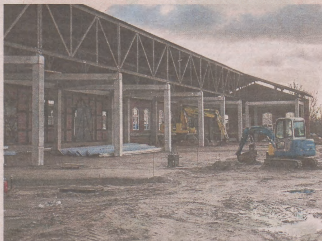
Budynek główny powstaje na bazie XIX wiecznego magazynu kolejowego
