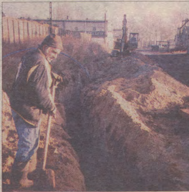
Przy budowie wodociągu pracował m.in. Jan Kasprzyk.
