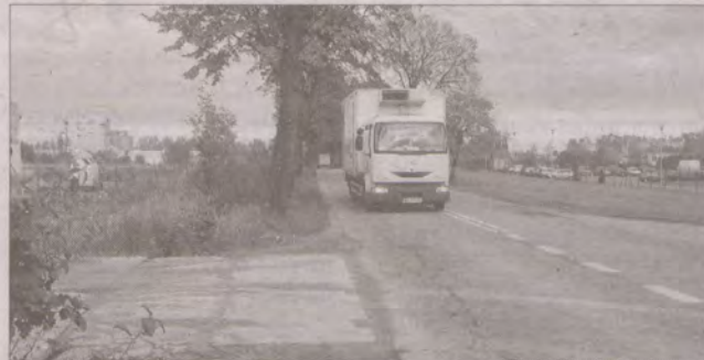
Budowa skrzyżowania ul. Zastawnej i Kupieckiej kosztować będzie ponad milion złotych.
