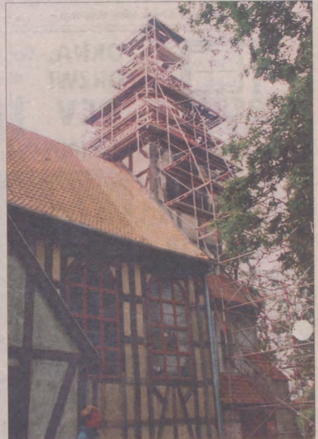
Wieża kościoła w Kieźmarku została odnowiona.
