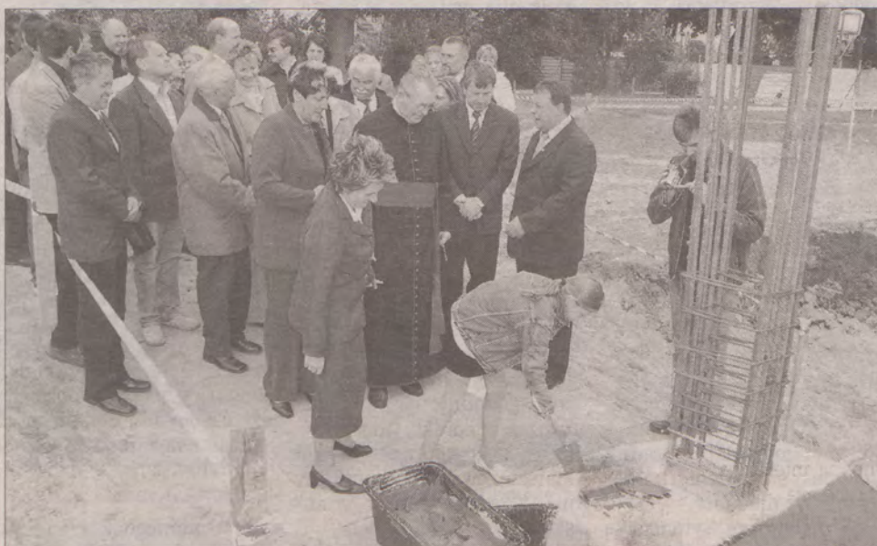
Kamień węgielny pod budowę hali wmurowała m.in. Marta Okoń, przedstawicielka szkolnego samorządu.
