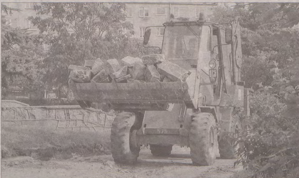
Trwają prace na skwerze przy ul. Wojska Polskiego w Pruszczu Gdańskim.
