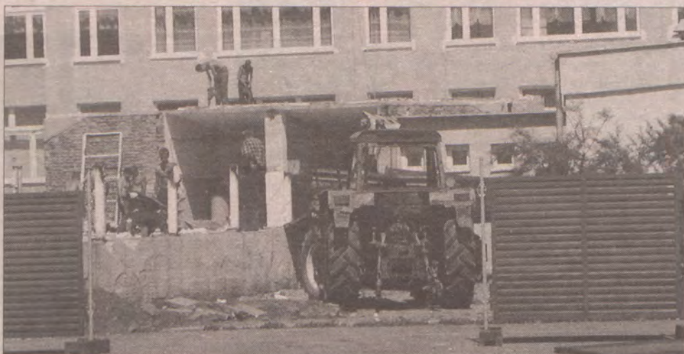
Prace przy remoncie basenu w Pruszcze Gdańskim prowadzi firma z Kielc.
