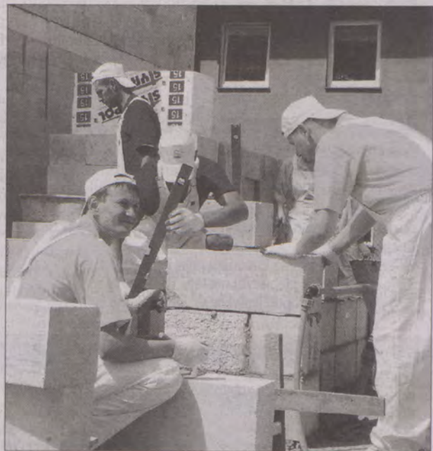
Na budowie kolejnego domu stawianego przy wsparciu Habitat for Humanity praca wre.
