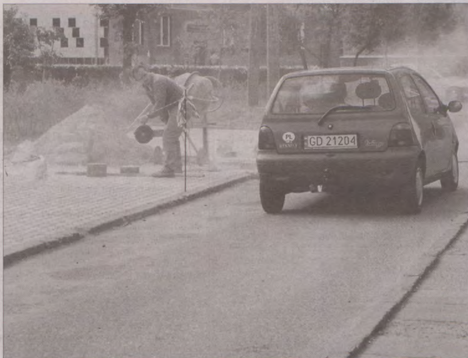
Prace na parkingu już zakończono, ale jeśli droga nie zostanie zamknięta, nie można zacząć remontu chodnika.
