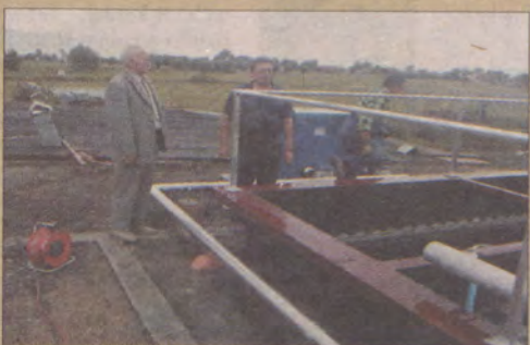
W ubiegłym roku w gminie Suchy Dąb, korzystając z unijnych pieniędzy, zbudowano oczyszczalnię ścieków.
