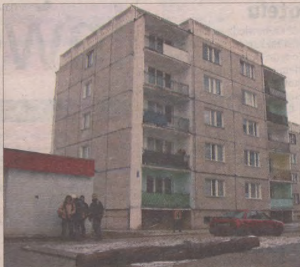
Na osiedlu Komarowo w 11 blokach z tzw. wielkiej płyty mieszkają 324 rodziny.
