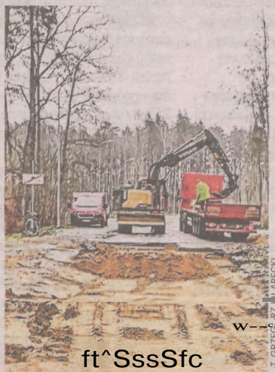
22 grudnia. Rozbiórka drogi
