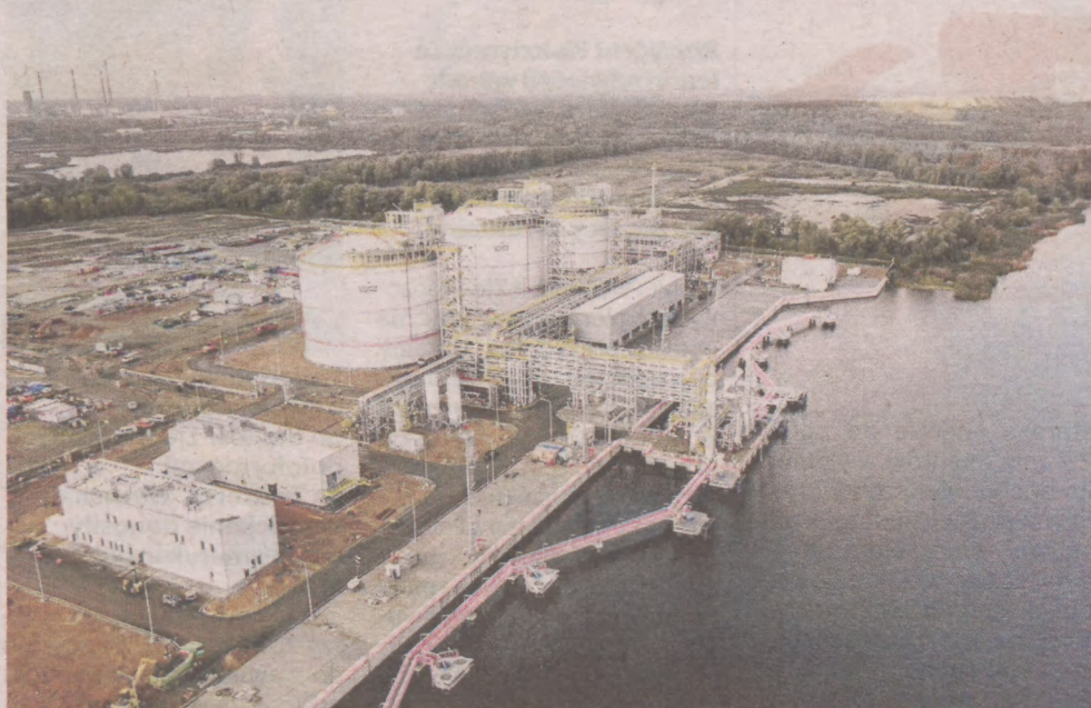
Zbiorniki magazynowych propanu oraz etylenu przy nabrzeżu w Policach
