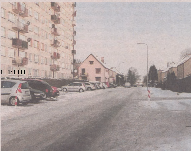
Ulica Batorego jest już w pełni przejezdna. Pozostało jeszcze nasadzenie nowych drzew, jako rekompensata za te wycięte
