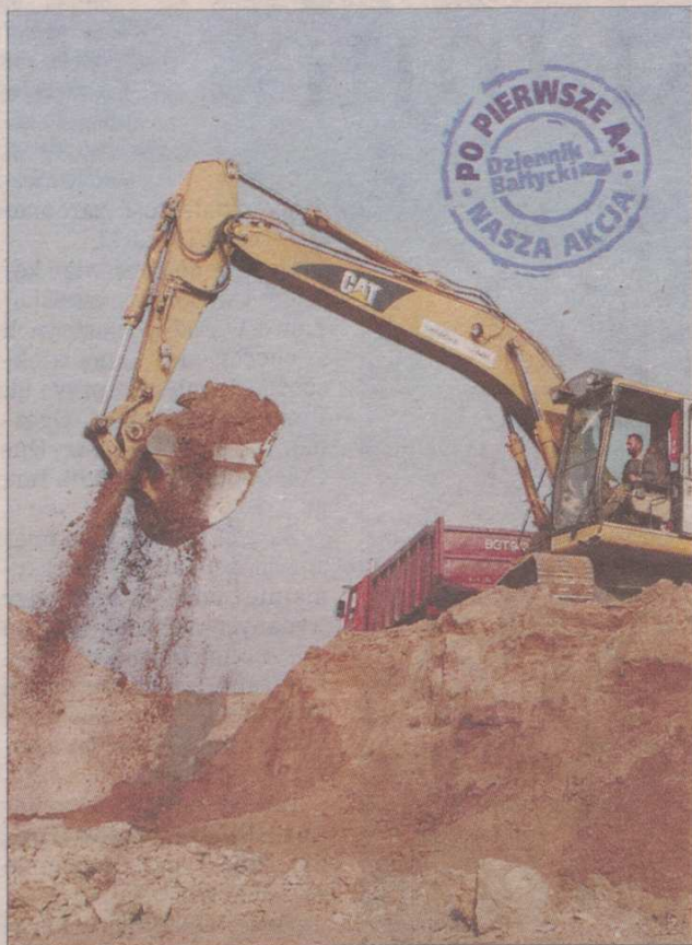
Na odcinku w Goszynie (gm. Tczew) trwają prace przy budowie A-1.
