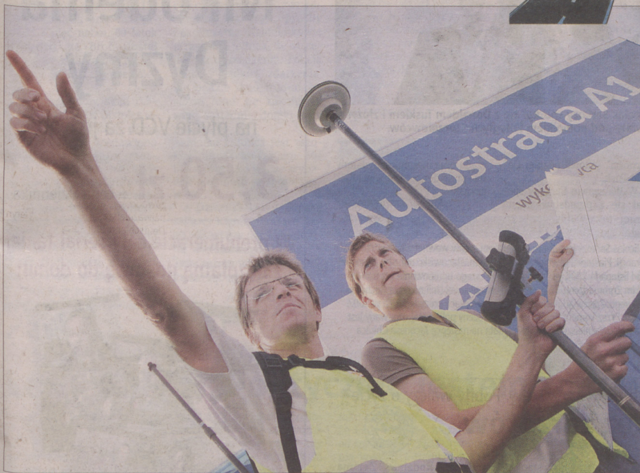
Björn Sanden i Paweł Potajłto, pracownicy Skanska SA, prowadzą pomiary przygotowawcze pod budowę autostrady A-1.
