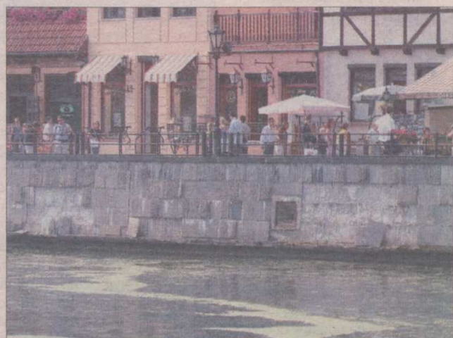
Od ścianki historycznego Długiego Pobrzeża, w centrum starego portu gdańskiego nad Motławą, odpadają masywne płyty granitowe.
