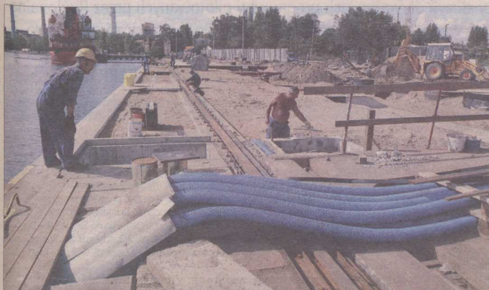
Prawie gotowy jest nowy, 92 – metrowy odcinek nabrzeża Szczecińskiego w porcie gdańskim, użytkowanego przez Gdański Terminal Kontenerowy SA.
