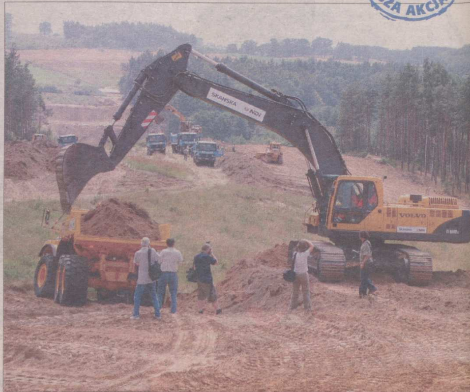
Rozpoczęły się roboty przy budowie autostrady A-1. Na początek potrzeba będzie kilkudziesięciu pracowników. Potem miejsc pracy będzie coraz więcej.
