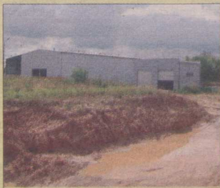
Plac budowy w Bierkowie
