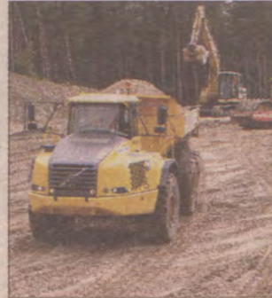
Budowa autostrady A1 rozpoczęła się w Goszynie.
