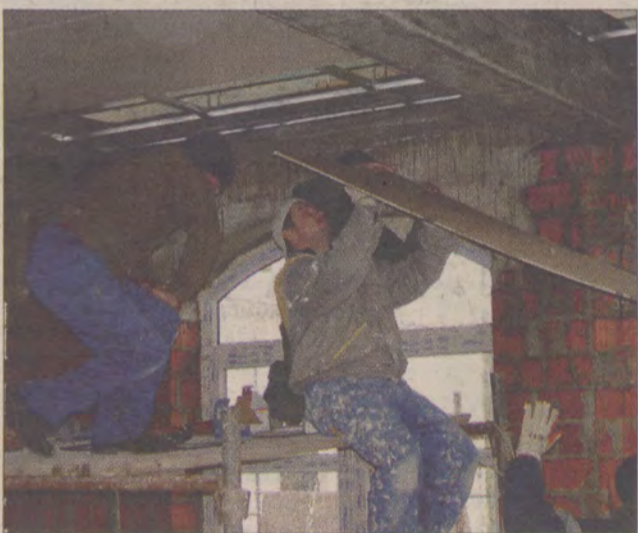
Trwają prace związane z rozbudową szkoły w Małej Słońcy.
