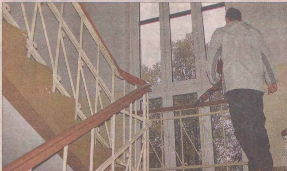
Budynek w 1997 r. przeszedł remont. Zostały wymienione m.in. okna.
