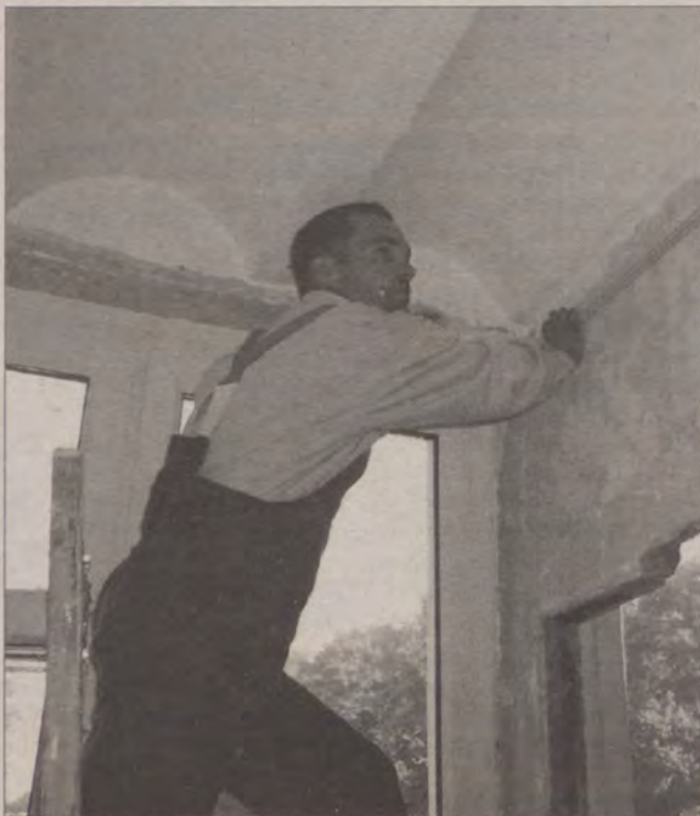
W Zespole Szkół w Morzeszczynie trwają prace remontowe. Na zdjęciu Krzysztof Isakowski.
