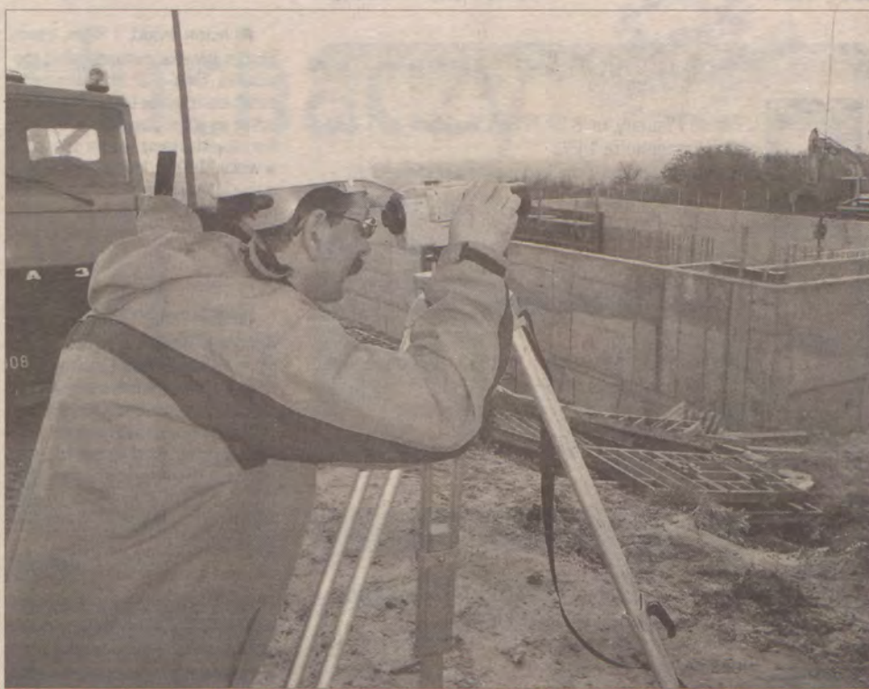
Budowa oczyszczalni była zadaniem priorytetowym dla władz gminy Gniew. Fot. Andrzej Polomski
