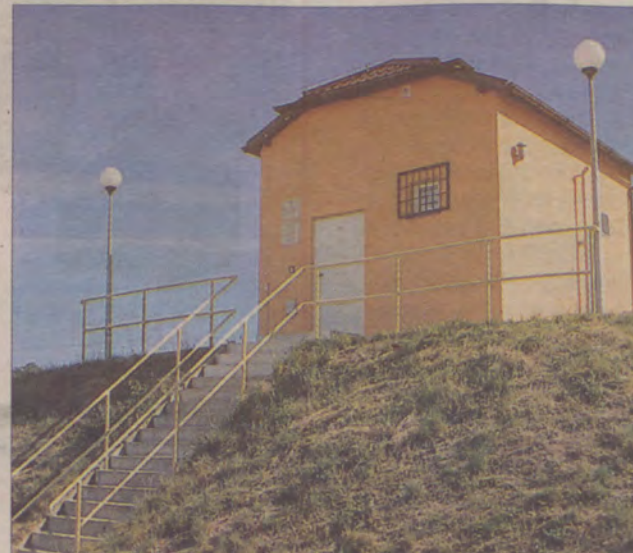
Kilka lat temu wybudowano oczyszczalnię ścieków w Majewie. W tym roku zakończono w tej miejscowości budowę kanalizacji.
