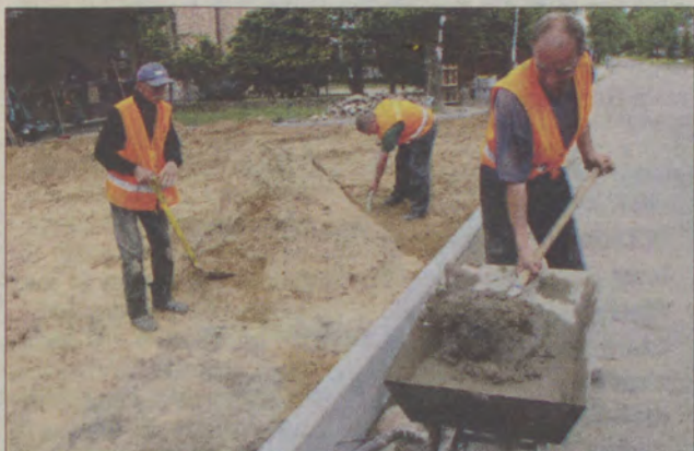
Przed sklepem w Brzuścach utwardzany jest teren.
